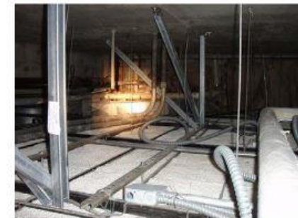
شکل پ ۶-۳۱- سقف لایه گچی یا مهار جانبی در فواصل ۱٫۸ تا ۲٫۴ متری
