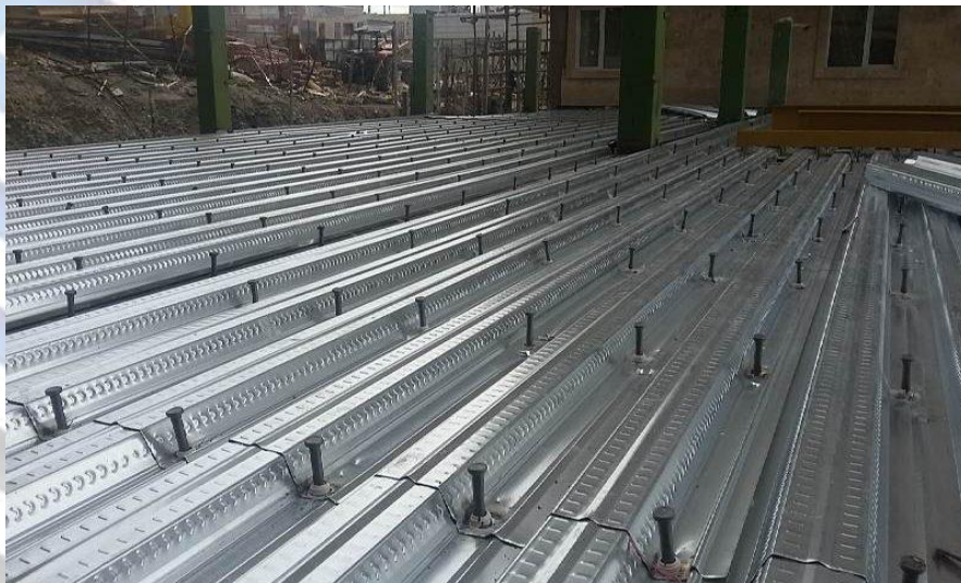
شکل (۱-۲۲) جزئیات سقف عرشه فولادی
