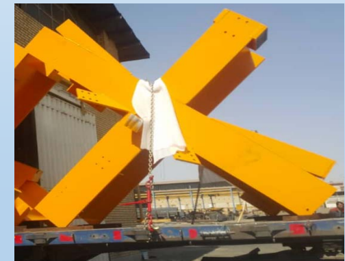
- استفاده از فوم در محل تماس با زنجیر بارگیری
