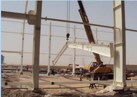
نصب تیرهای سقف سوله از داخل سازه
