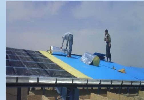
پوشش توری مرغی ، پشم شیشه و ورق کرکره
