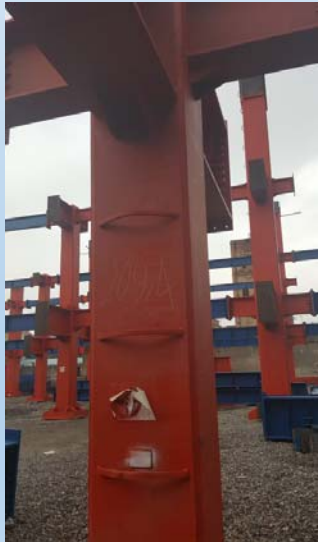
اجرای پله موقت در بدنه ستون
