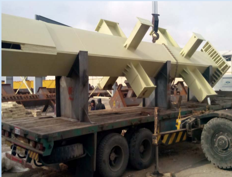
- استفاده از تکیه‌گاه در حمل ( Saddle )
