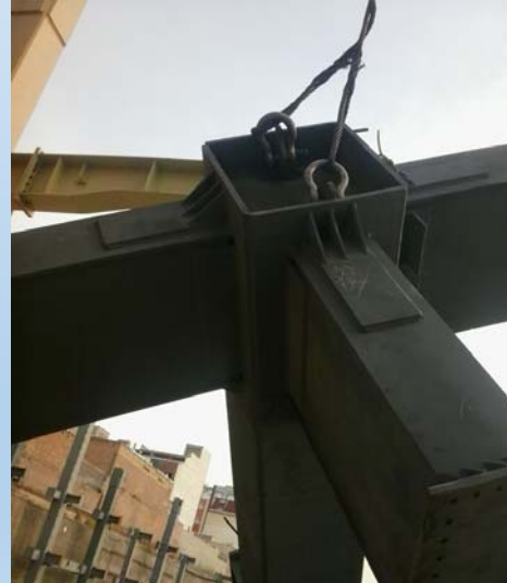
اجرای قلاب در ستون جهت بستن پین شکل
