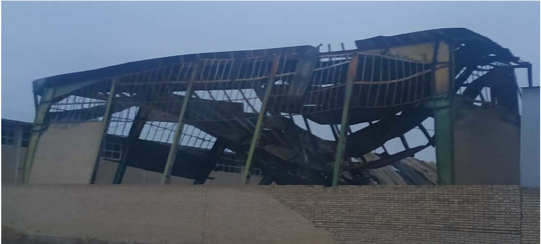
عدم محافظت سوله در برابر آتش
