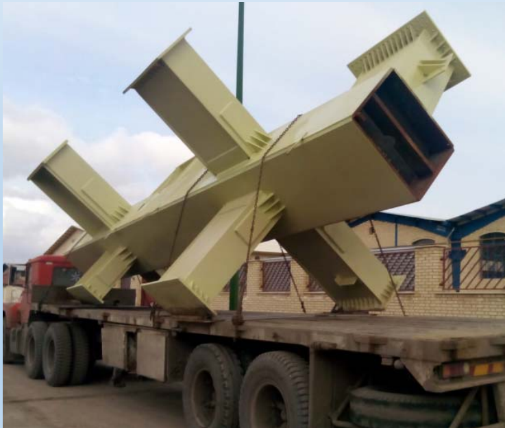
به دلیل محدودیت وزن طول ستون ۹ متر لحاظ گردیده است
