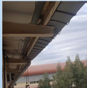
ایجاد آبرو با ورق گالوانیزه و بسط های نگهدارنده
