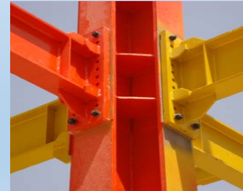
نصب اولیه قطعات سازه
