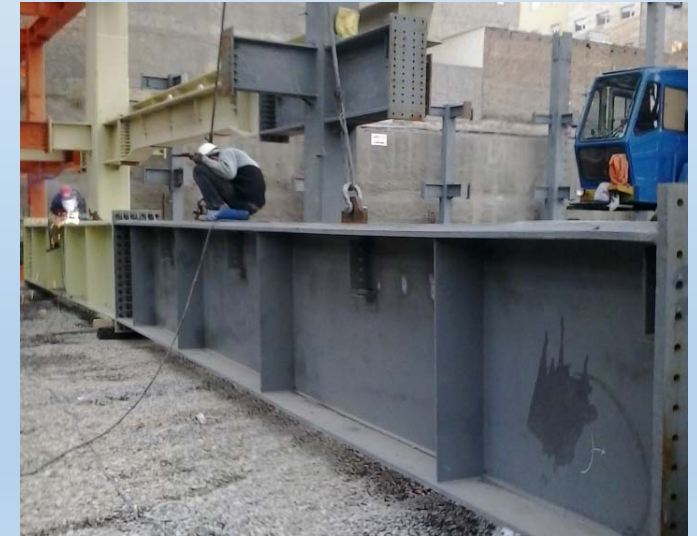
اجرای قلاب در تیر جهت بستن پین شکل
