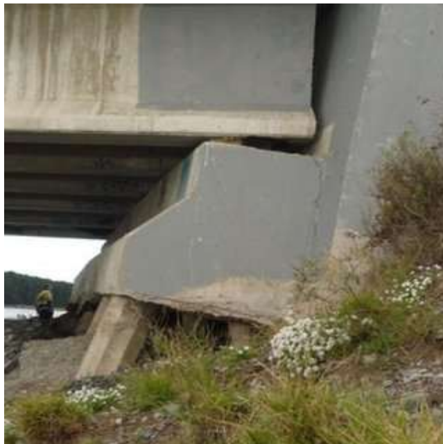
شکل ۲-۳۷- نشست نامساوی و چرخش کوله
