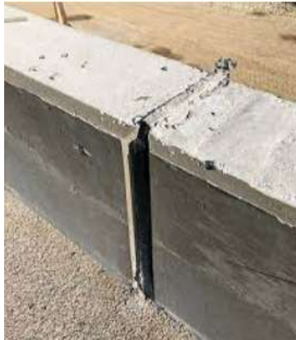
شکل پ-۱-۶: درز انبساط دیوار
