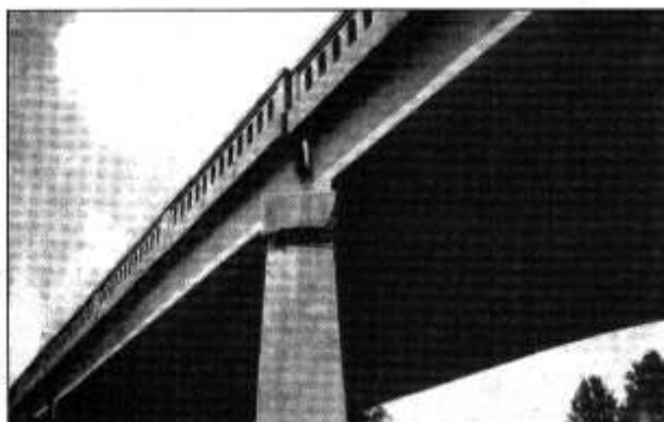
شکل ۲-۳۸- نشست نامساوی پایه‌ها باعث نشست روسازه شده است
