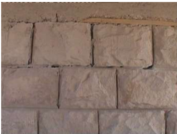
شکل ۲-۵۰- خالی شدن بندها مقدمه ای برای لق شدن سنگها است (خدابنده، ۱۳۸۹).
