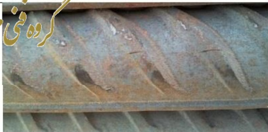
شکل ۳ ترک روی آج میلگرد قطر ۳۲
