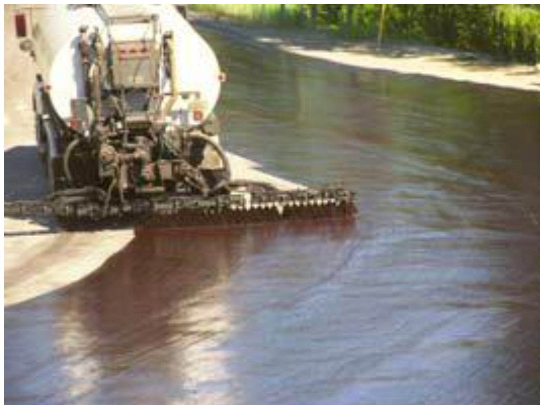
اجرای امولسیون قیر در بستر راه
