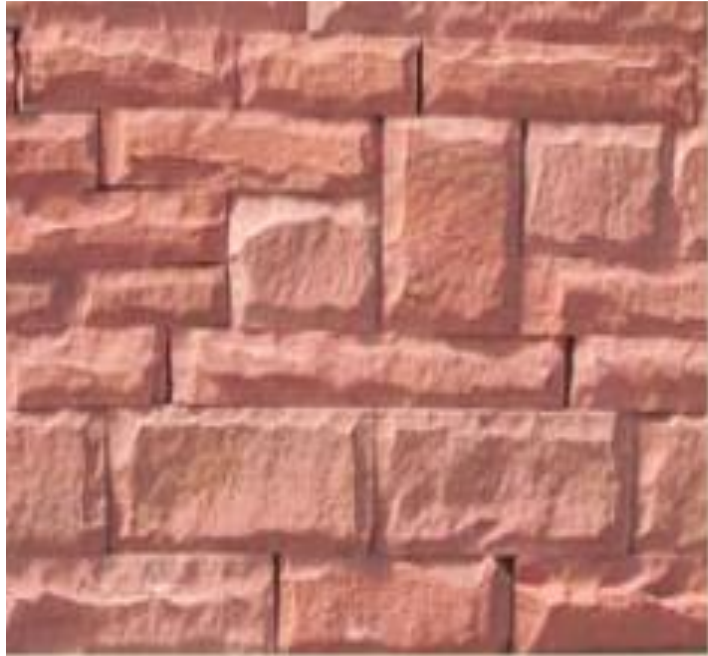
تصویر شماره ۱۹.۴. دیوار چینی با سنگ بادکوبه‌ای
