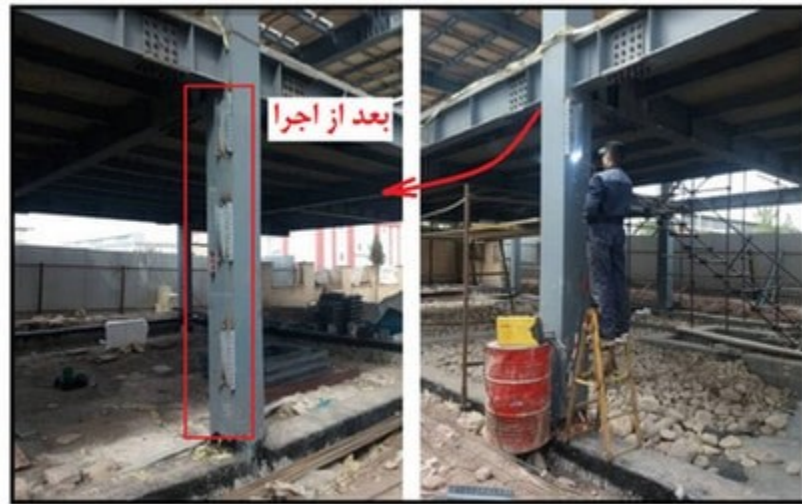
شکل ۸۱- اجرای قطعات اتصال در سازه‌های فولادی
