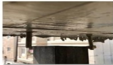
فاصله رعایت شده وادار با تیر یا سقف
