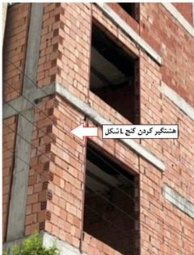
شکل ۶۹- هشتگیر کردن کنج L شکل دیوارهای لبه کنسول
