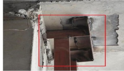
اتصال مستقیم وادار عمودی به سقف یا تیر
