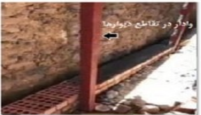
اجرای دیوارهای متقاطع با وادار
