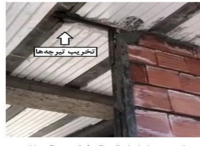
تخریب پاشنه تیرچه‌ها برای اتصال میلگرد کمکی به میلگرد طولی تیرچه و برقراری اتصال با وادار انتهایی
