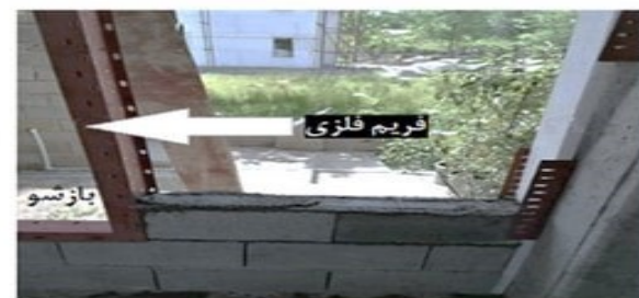
بازشو بدون تیز به اجرای وادار، سوراخ‌های لوبیایی برای مهار میلگرد بستر
