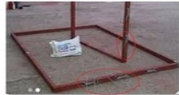
شاخک میلگردهای بستر و گیره‌های اتصال روی فریم فلزی
