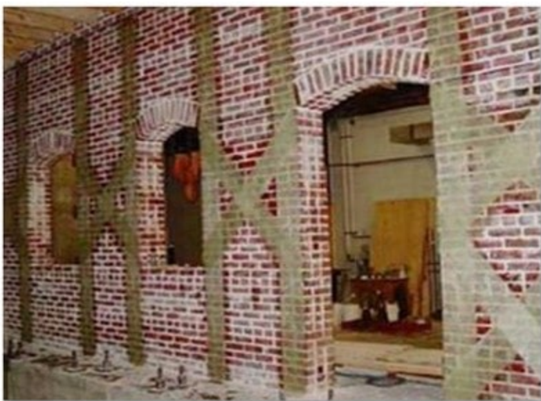
شکل ۱۰۰- اجرای الیاف کربن در دیوارهای قدیمی
