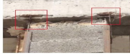
تخریب المان‌های سازمانی و استفاده از میلگردهای آن‌ها برای اتصال وادارها
