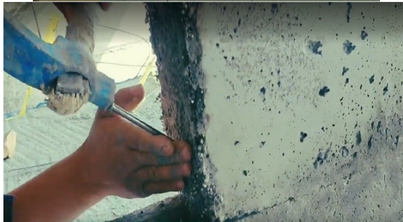
اتصال پانلهای پایه سیمانی با میخ به یکدیگر
