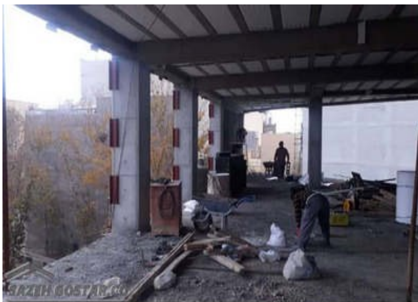
ناودانی کار گذاشته شده قبل از اجرای دیوار برای ایجاد فاصله و مهار
