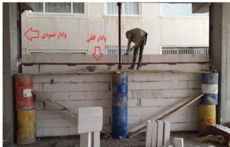
شکل ۵۵- اجرای وادار افقی (تیرک) مطابق ضابطه ۸۱۹
