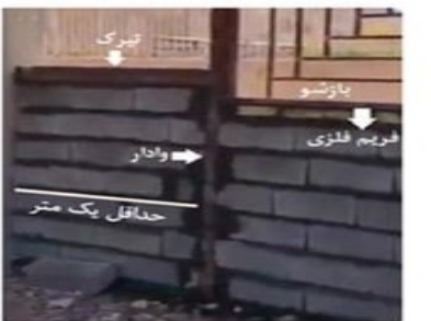
رعایت فاصله یک متری وادار از المان قائم سازه‌ای
