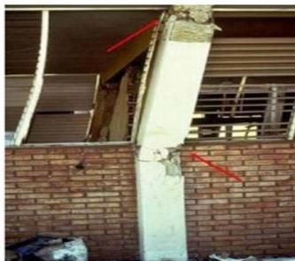
عدم جداسازی دیواری که ادامه پیدا نکرده است و تشکیل ستون کوتاه
