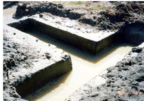
شکل ۳-۶۱ حفر ترانشه های T و صلیبی شکل به کمک ماشین های حفار هیدرومیل و چنگک
