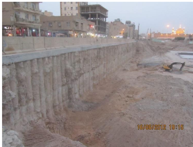
شکل پ ۱-۱۱ پایداری گود با روش شمع مماسی
