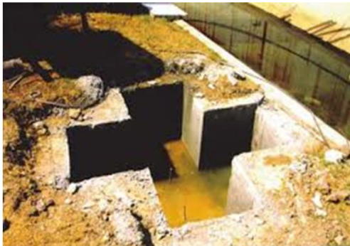
شکل ۳-۶۱ حفر ترانشه های T و صلیبی شکل به کمک ماشین های حفار هیدرومیل و چنگک
