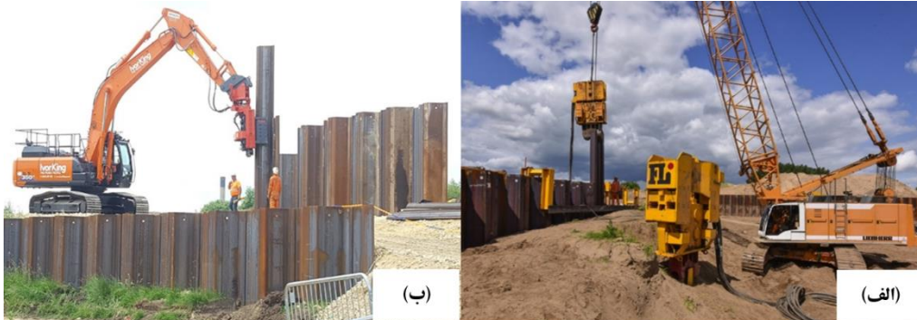
شکل ۳-۴۷ رانش مقطع سپری در خاک به کمک چکش سپرکوب: (الف) اتصال چکش به بیل مکانیکی، (ب) اتصال چکش به جرثقیل
