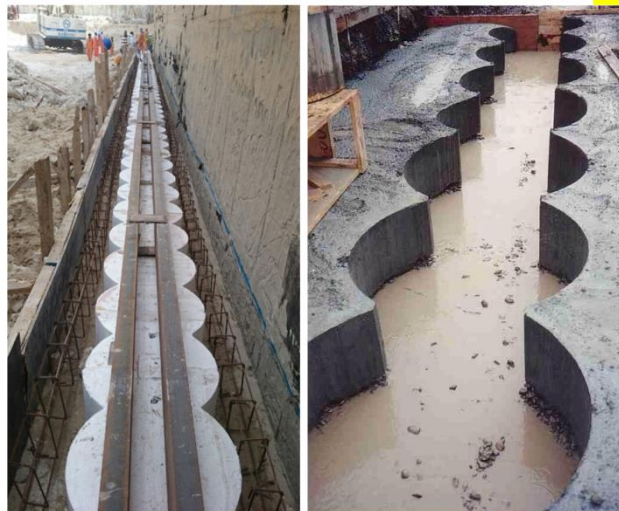
شکل ۳-۴۶ اجرای دیواره هادی بتنی در سر چاه به کمک قالب پلی استایرن در اجرای دیوار شمع مماسی.
