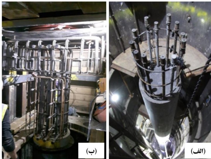
شکل ۳-۳۹ نمونه‌ای از اجرای ستون بتنی داخل چاه و از پایین به بالا؛ (الف) بتن‌ریزی مرحله به مرحله ستون از پایین به سمت بالا و مهار ستون ریخته شده به دیواره چاه - (ب) قرار دادن میلگردهای انتظار با اتصال مکانیکی (کوپلر) جهت اتصال ستون به تیر
