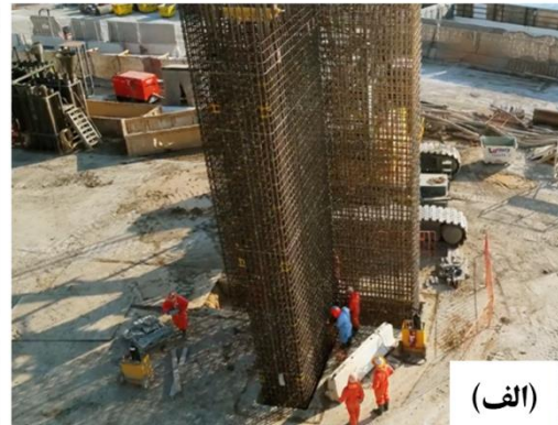
شکل ۳-۶۲ اجرای دیوار دیافراگمی به شکل T، (الف) جایگذاری شبکه میلگرد T شکل، (ب) مقطع بتنی نهایی دیوار به شکل T
