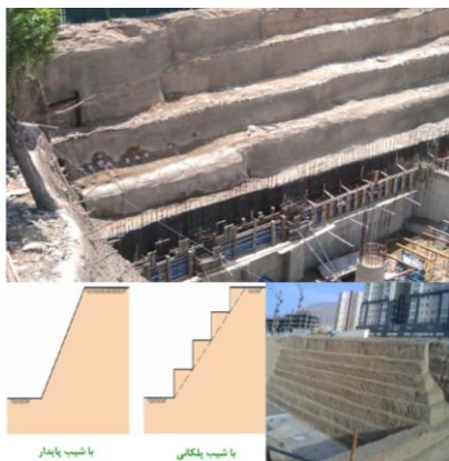
شکل پ ۱-۲ روش پایدارسازی با شیب پایدار یا پلکانی
