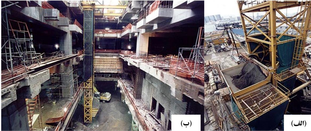
شکل ۵-۱ (الف) انتقال خاک برداشته شده از داخل بازشدگی توسط جرثقیل، (ب) دال سقف سه طبقه زیرزمین، خاک زیر پایین ترین دال در حال حفاری است و در مرکز جمع‌آوری می‌شود تا توسط بالابر به سطح منتقل گردد.
