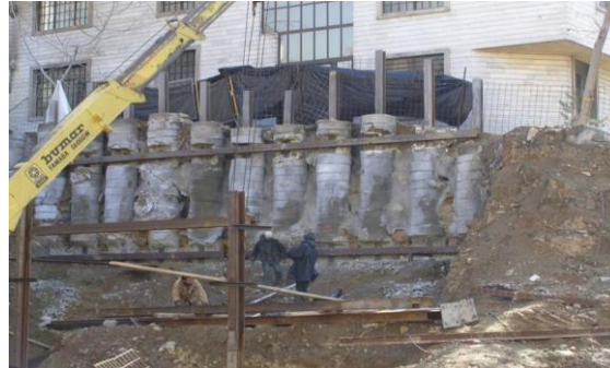
شکل پ ۱-۱۳ پایدارسازی گود با روش شمع سرباز با فاصله
