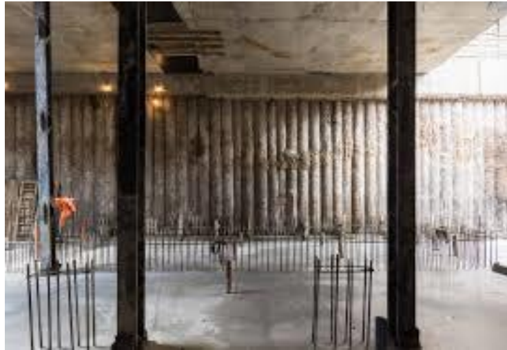
شکل ۳-۵۴ اجرای دیوار شمع‌های مماسی به‌صورت مدفون برای ساخت سازه به‌روش بالا-پایین (دیوار حائل دائمی سازه پس از انجام خاکبرداری و هنگام تکمیل سازه هر زیرزمین بر روی دیوار شمع‌ی و به‌صورت مرحله‌ای از بالا-پایین اجرا می‌شود)
