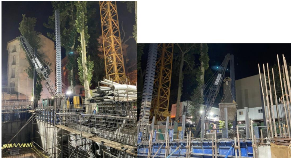
شکل ۳-۸۱ انتقال خاک از داخل گود به بیرون به وسیله جرثقیل بوم خشک که یک مخزن تخلیه خاک از آن معلق است
