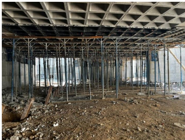
شکل ۳-۱۰۹ قالب‌بندی و اجرای سقف از نوع دال مجوف (وافل) روی جک‌های مستقر شده بر روی سطح خاک
