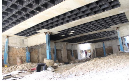
شکل ۱-۱۲ پروژه یوسف آباد - الگوی بومی - اسکلت مختلط فولادی-بتنی (CFT)، سقف وافل و استفاده از پنل‌های نیمه‌پیش‌ساخته دیوار حائل به عنوان اجزای کمکی مابین ستون‌های اصلی - عمق گودبرداری ۱۷ متر
