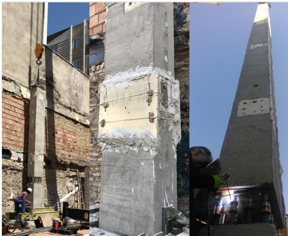
شکل ۳-۲۴ انجام وصله ستون پیش ساخته بتنی به کمک وصله مکانیکی و استفاده از گروت ریزی
