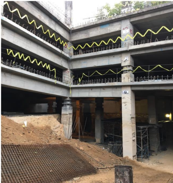
شکل ۱-۱۳ پروژه پارکینگ طبقاتی نیایش - الگوی بومی - اسکلت بتنی با ستون‌های پیش‌ساخته - عمق گودبرداری ۳۵ متر
