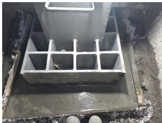
شکل ۳-۲۷ نصب و ملات‌ریزی ستون دارای کف‌ستون بر روی بولت‌های مهار شده در شمع
