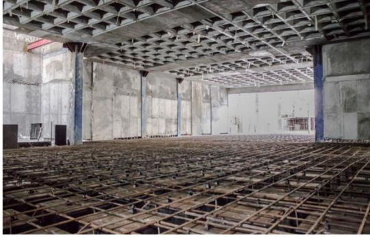
شکل ۱-۱۲ پروژه یوسف آباد - الگوی بومی - اسکلت مختلط فولادی-بتنی (CFT)، سقف وافل و استفاده از پنل‌های نیمه‌پیش‌ساخته دیوار حائل به عنوان اجزای کمکی مابین ستون‌های اصلی - عمق گودبرداری ۱۷ متر
