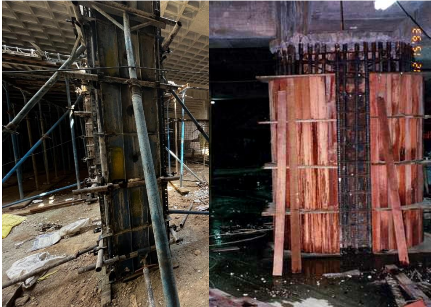
شکل ۳-۳۵ قالب بندی چوبی و فلزی ستون مختلط بتنی.
