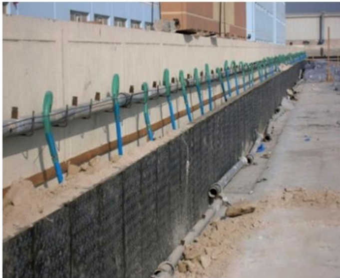
ج) نمونه اجرا شده چاه نقطه ای شکل ۳-۱۱۶ خشک اندازی اطراف گودبرداری.
