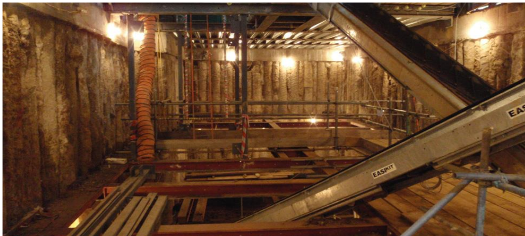
شکل ۳-۸۵ تخلیه خاک‌های کنده شده به بیرون از سایت از طریق بازشوهای خروجی سقف به وسیله نوارهای نقاله در اجرای سازه به روش بالا-پایین
