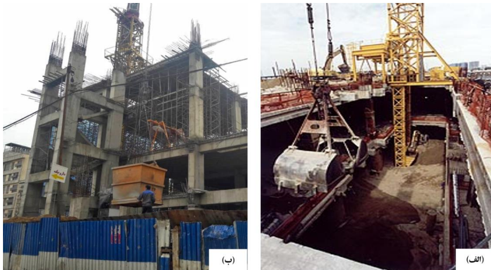
شکل ۳-۷۹ تصاویری از تخلیه خاک به وسیله، الف) چنگک و ب) مخزن خود بازشو که از جرثقیل آویزان و جهت انتقال خاک به بیرون از پروژه استفاده می‌شود
