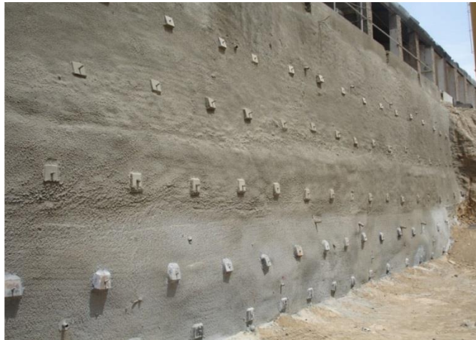
شکل پ ۱-۱۶ پایدارسازی گود با میخ کوبی دیواره جدول پ ۱-۸ مشخصات روش میخ کوبی دیواره
