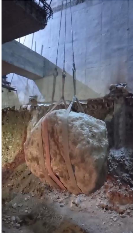
شکل ۳-۱۲۹ خارج ساختن سنگ از عمق ۲۵ متری در پروژه ساخت به روش بالا-پایین
