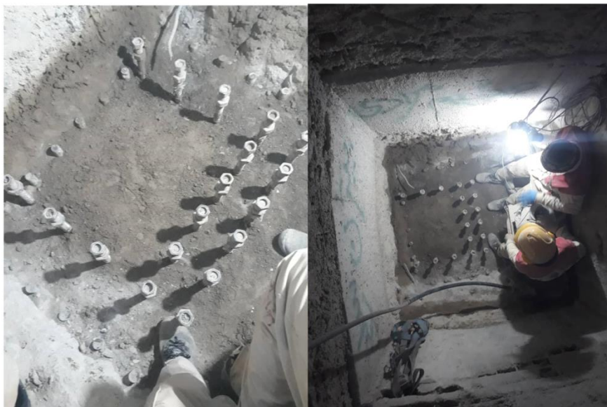
شکل ۳-۲۵ مهارهای اجرا شده در شمع پس از بتن ریزی شمع و خارج کردن شابلون صفحه ستون
