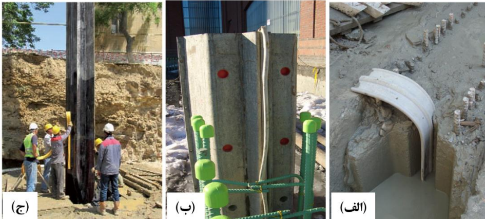
شکل ۳-۵۸ (الف) نصب صفحات انتهایی در ترانشه، (ب) نصب نوار آب‌بند داخل شیار صفحات انتهایی، (ج) قرار گرفتن نوار آب‌بند داخل قطعه‌ای از دیوار که بتن‌ریزی شده است و با بتن‌ریزی قطعه مجاور نوار آب‌بند درز بین دو قطعه را پر خواهد کرد
