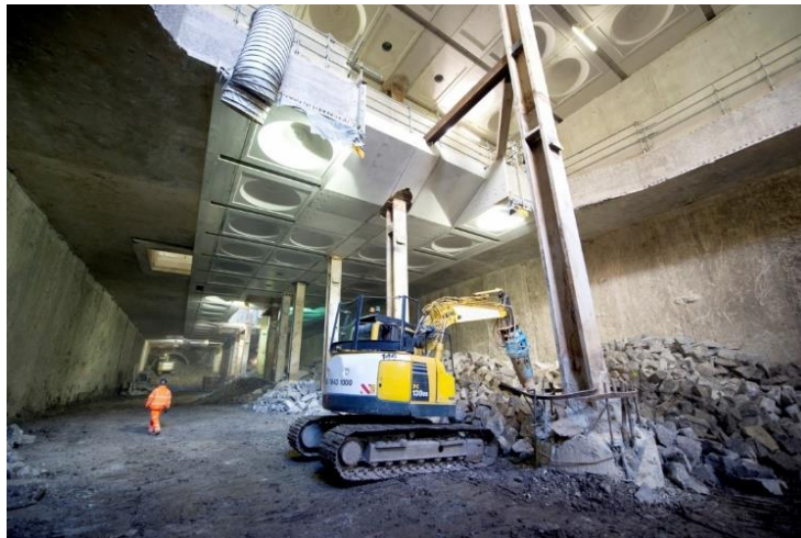
شکل ۳-۴۱ خرد کردن ستون سیمانی پرکننده اطراف ستون اصلی سازه به وسیله پیکور
