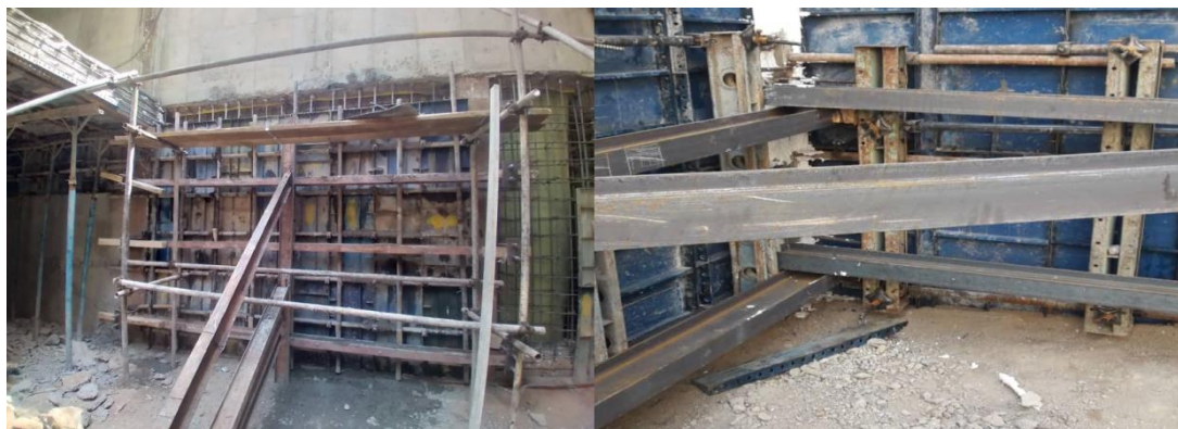
شکل ۳-۱۰۲ نمونه‌ای از نصب پشت‌بند و مهار قالب یکطرفه دیوار حائل به کمک ستون‌های سازه
