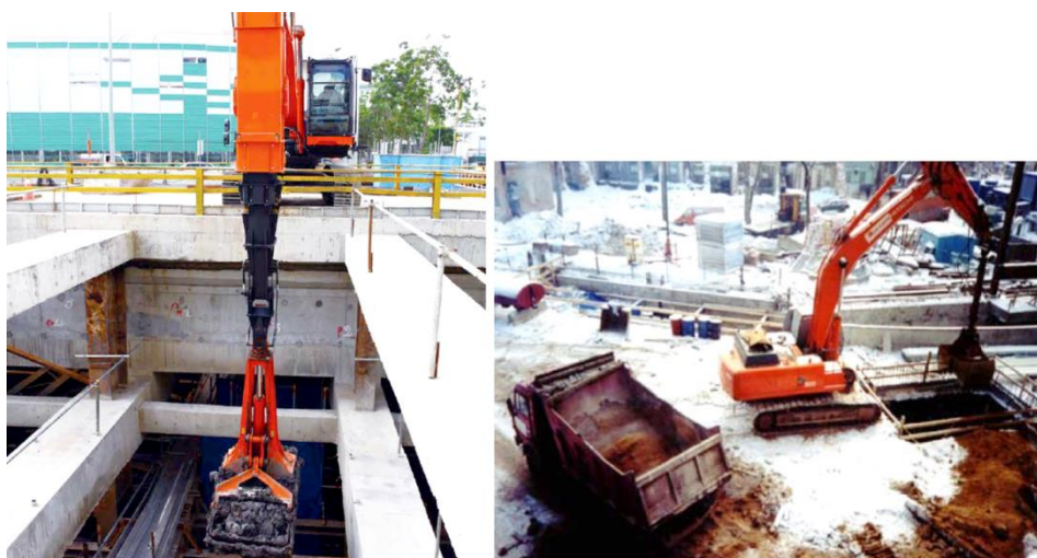
شکل ۳-۷۸ تصاویری از تخلیه خاک به وسیله بیل مکانیکی بازو تلسکوپی از یک پروژه در حال اجرا به روش بالا-پایین. ابعاد کوچک بازشوی ایجاد شده در دیافراگم سقف در تصویر سمت راست مشخص است.
