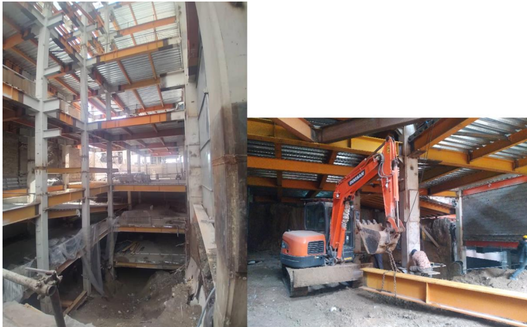
شکل ۱-۱۶ پروژه پاسداران - الگوی بومی - اسکلت فلزی- سقف عرشه فولادی- عمق گودبرداری ۱۸ متر.
