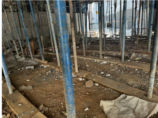
شکل ۳-۱۱۰ استفاده از الوارهای چوبی در زیر جک های سقف به منظور توزیع مناسب بار سقف تازه ریخته شده و مابقی ملحقات قالب بندی به سطح زمین و جلوگیری از فرورفتن جک ها در خاک و نشست آنها هنگام اجرای سقف
