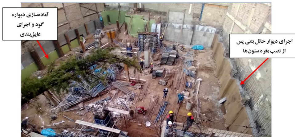
شکل ۳-۹۳ آماده‌سازی جهت اجرای بخش‌های مختلف عملیات ساخت و تعریف جبهه‌های کاری مختلف در پروژه (اسکلت بتنی و ستون‌های با مغزه فولادی در طبقات زیرزمین).
