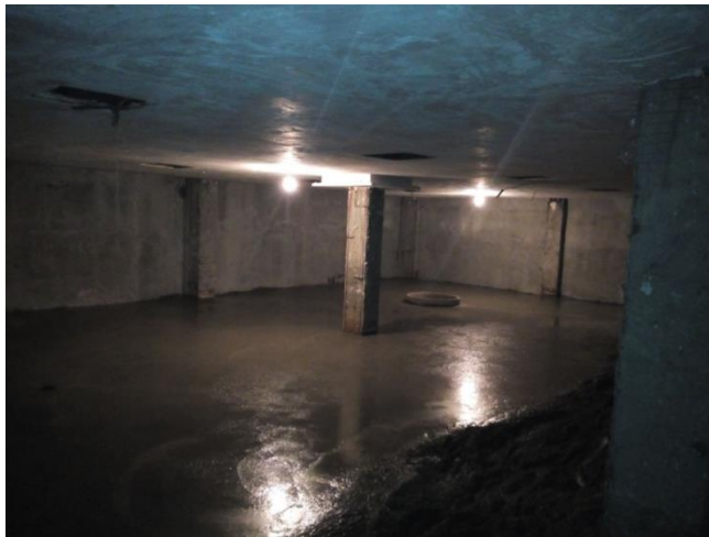
شکل ۳-۱۲۶ نمونه اجرای بتن آب‌بند بر روی فونداسیون
