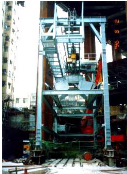
شکل ۳-۸۳ استفاده از جرثقیل دروازه‌ای جهت بیرون کشیدن خاک در یک پروژه ساخت به روش بالا-پایین.
