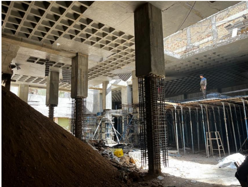
شکل ۳-۳۴ آرماتوربندی اطراف مغزه فولادی برای اجرای ستون مختلط بتنی.
