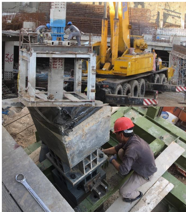
شکل ۲۳-۳ انجام وصله ستون پیش ساخته بتنی به کمک فلنج فولادی و پیچ
