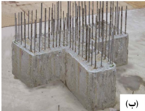
شکل ۳-۶۲ اجرای دیوار دیافراگمی به شکل T، (الف) جایگذاری شبکه میلگرد T شکل، (ب) مقطع بتنی نهایی دیوار به شکل T
