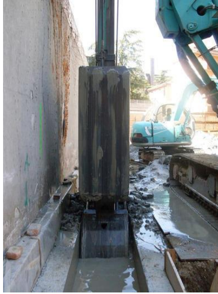
شکل ۳-۵۷ حفاری ترانشه دیوار دیافراگمی، به وسیله چنگک از طریق دیواره‌های سر ترانشه و همزمان با چرخش گل حفاری.
