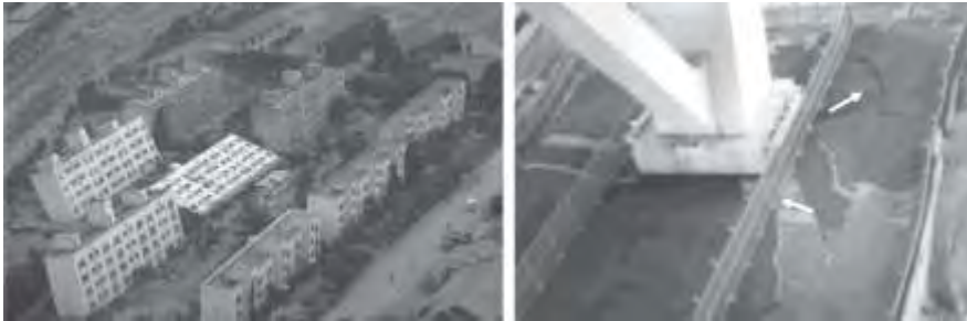
شکل ۱-۵۴ خسارات ناشی از روانگرایی در زلزله‌های نیگاتا (سمت چپ) جوشش ماسه در کنار پایه پل در زلزله کوبه (سمت راست)
