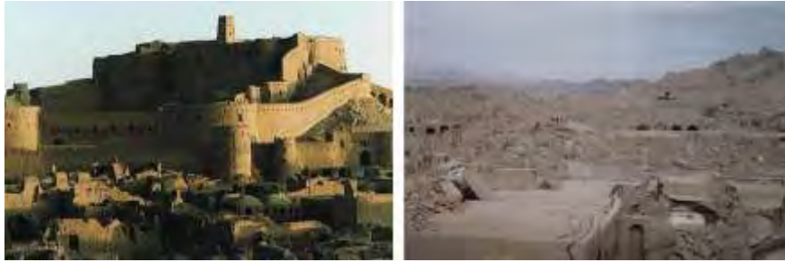
شکل ۱-۲۴ بنای تاریخی ارگ بم بعد و قبل از زلزله
