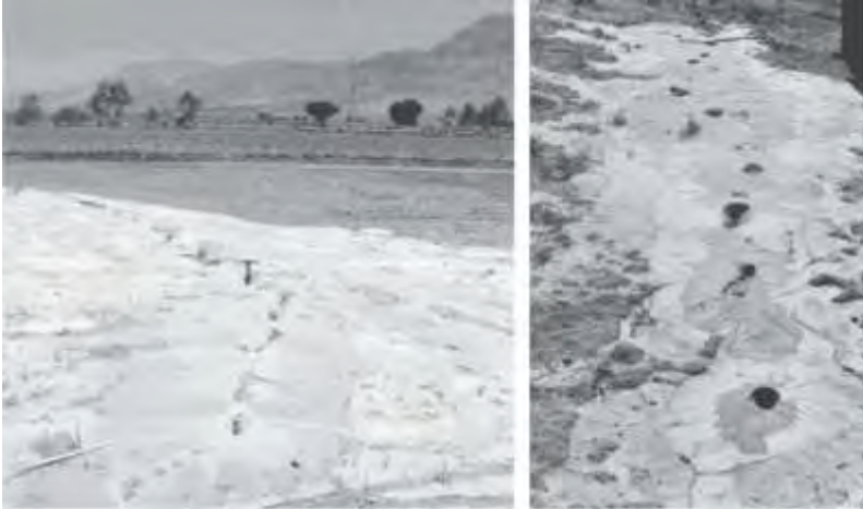
شکل ۱-۵۳ جوشش خاک در زلزله ترکیه (شکل چپ) و زلزله هند (شکل راست)
