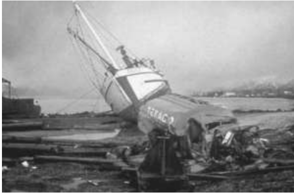
شکل ۱-۱۶ خسارات ناشی از سونامی زلزله آلاسکا (۱۹۶۴)
