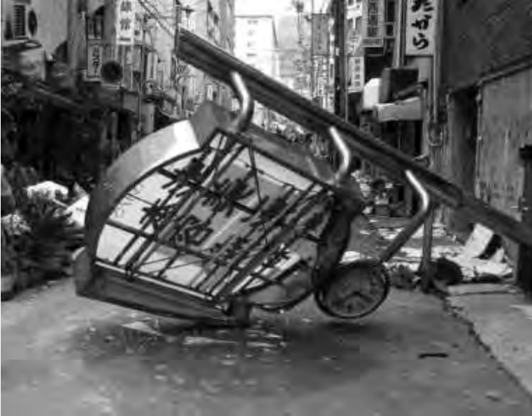
شکل ۵-۱۲ خرابی در یک تابلو تبلیغاتی در حین زلزله کوبه (۱۹۹۵)
