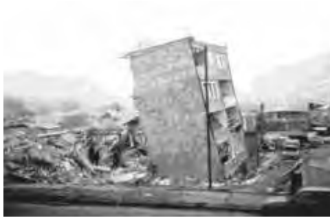
شکل ۱-۲۱ خرابی‌های ایجاد شده در زلزله ارمنستان (۱۹۸۸)
