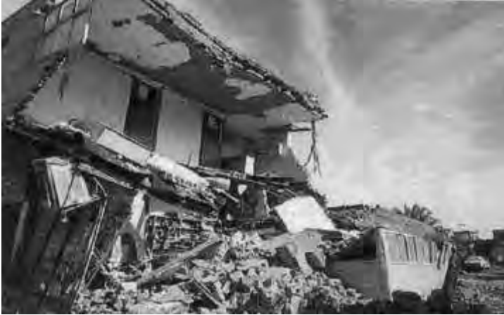
شکل ۹-۱ ساختمان مصالح بنائی - زلزله بم
