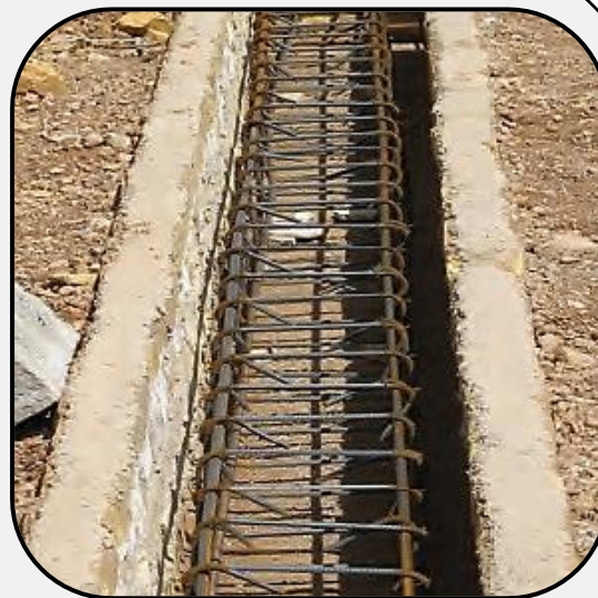
(اجرای میلگردهای شناژها)
