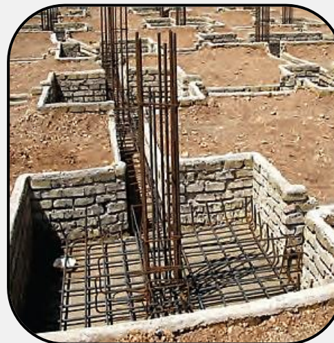
(اجرای میلگردهای ریشه انتظار برای سازه‌های بتنی)
