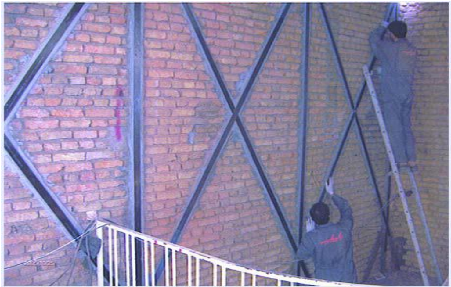
نحوه اجرا و نصب نوارهای FRP
