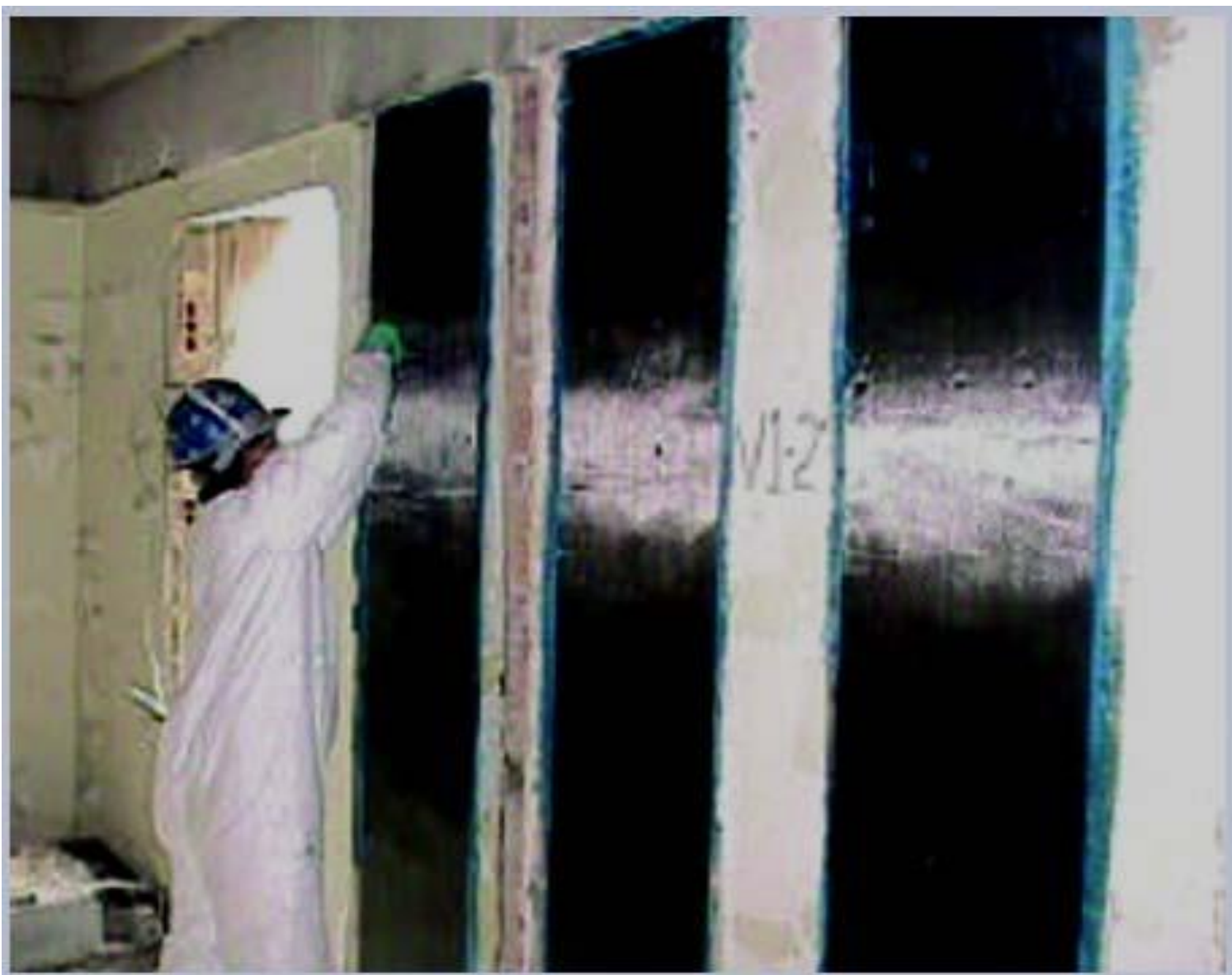
نحوه اجرا و نصب نوارهای FRP
