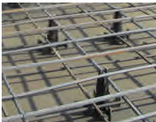
نوع قرار گیری اسپیسر های سقف
