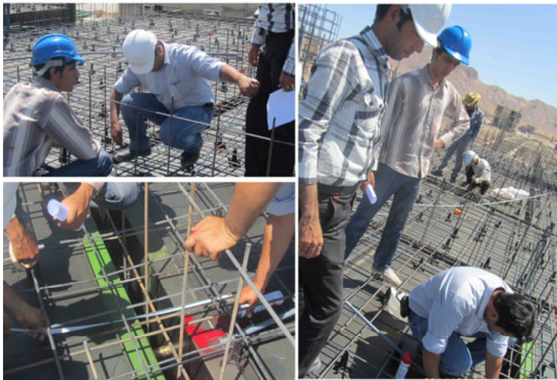
• مشخص کردن محل داکت ها
