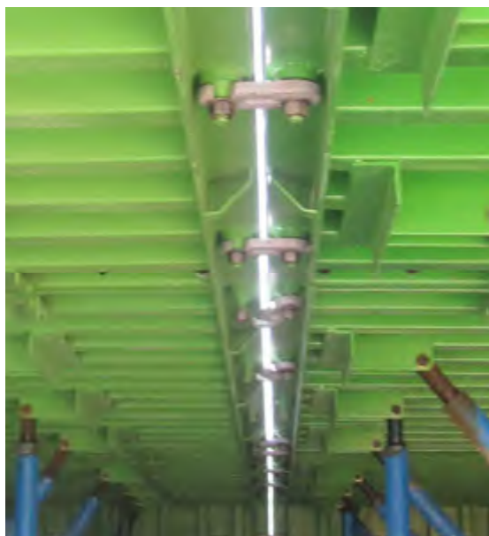
اتصال قالب ها بوسیله قلاب اتصال
