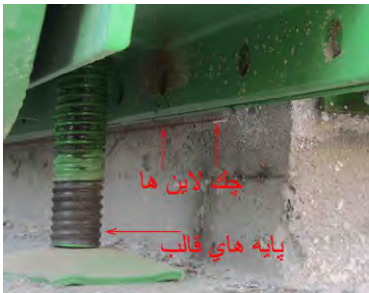
قرار گیری قالب در ارتفاع چك لاین ها
