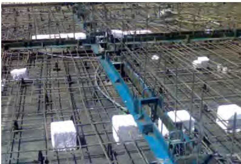
اجرای رامکا روی سقف
