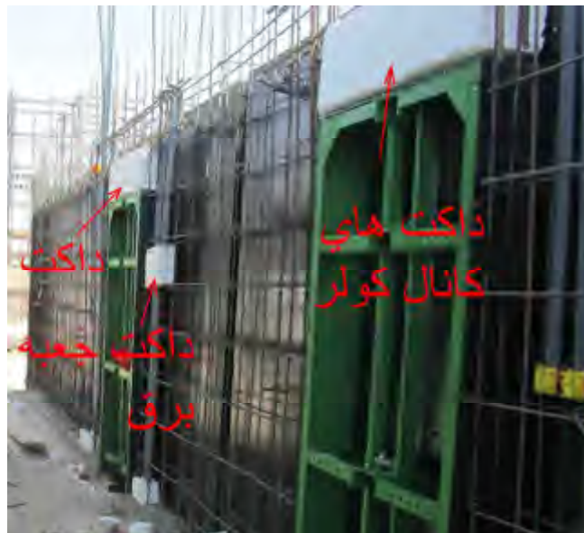
مشخص کردن محل داکت های دیوار
