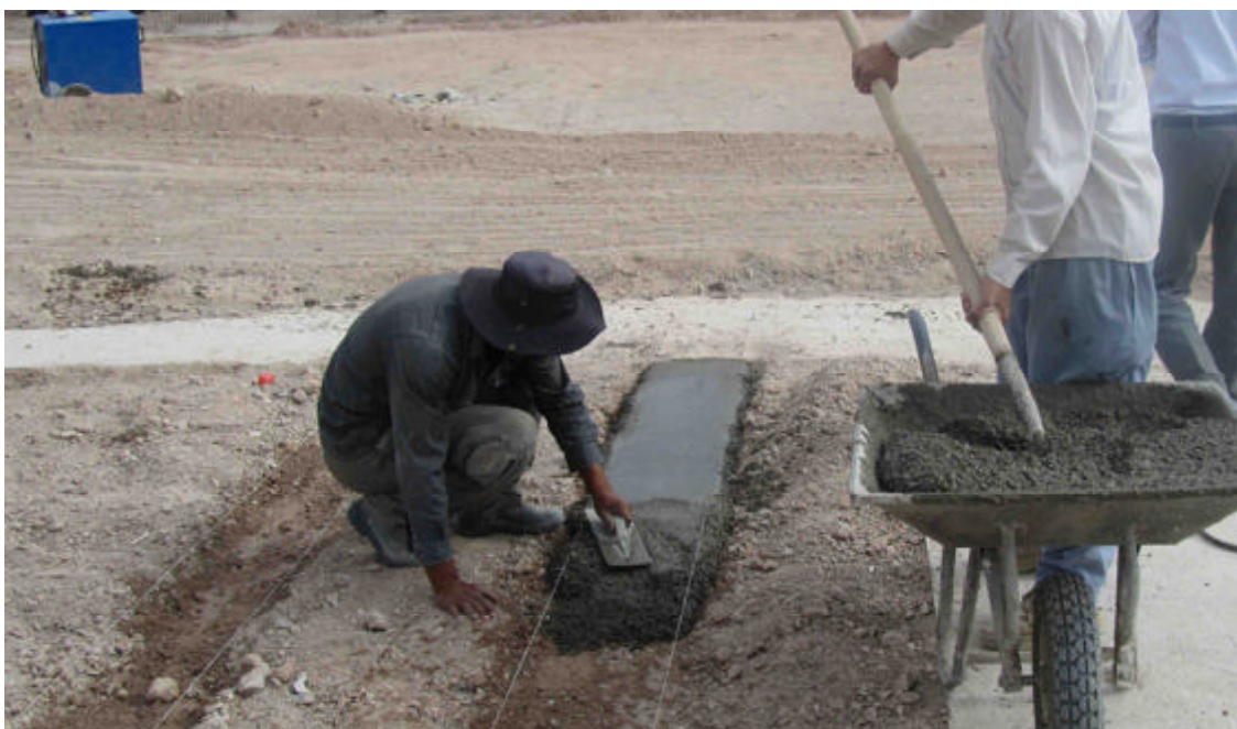
• ساخت محل حرکت چرخهای قالب
