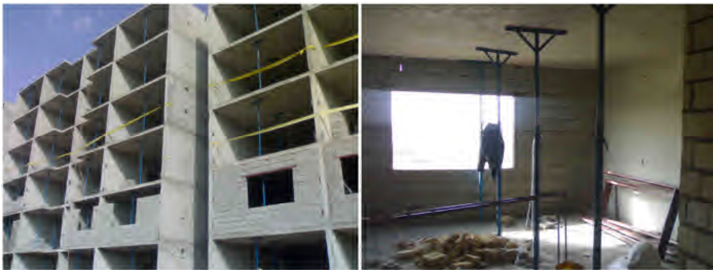
• دیوارهای خارجی با استفاده از بلوک های سیمانی سبک
