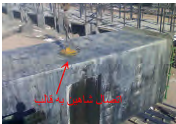
اتصال شاهین به مرکز ثقل قالب
