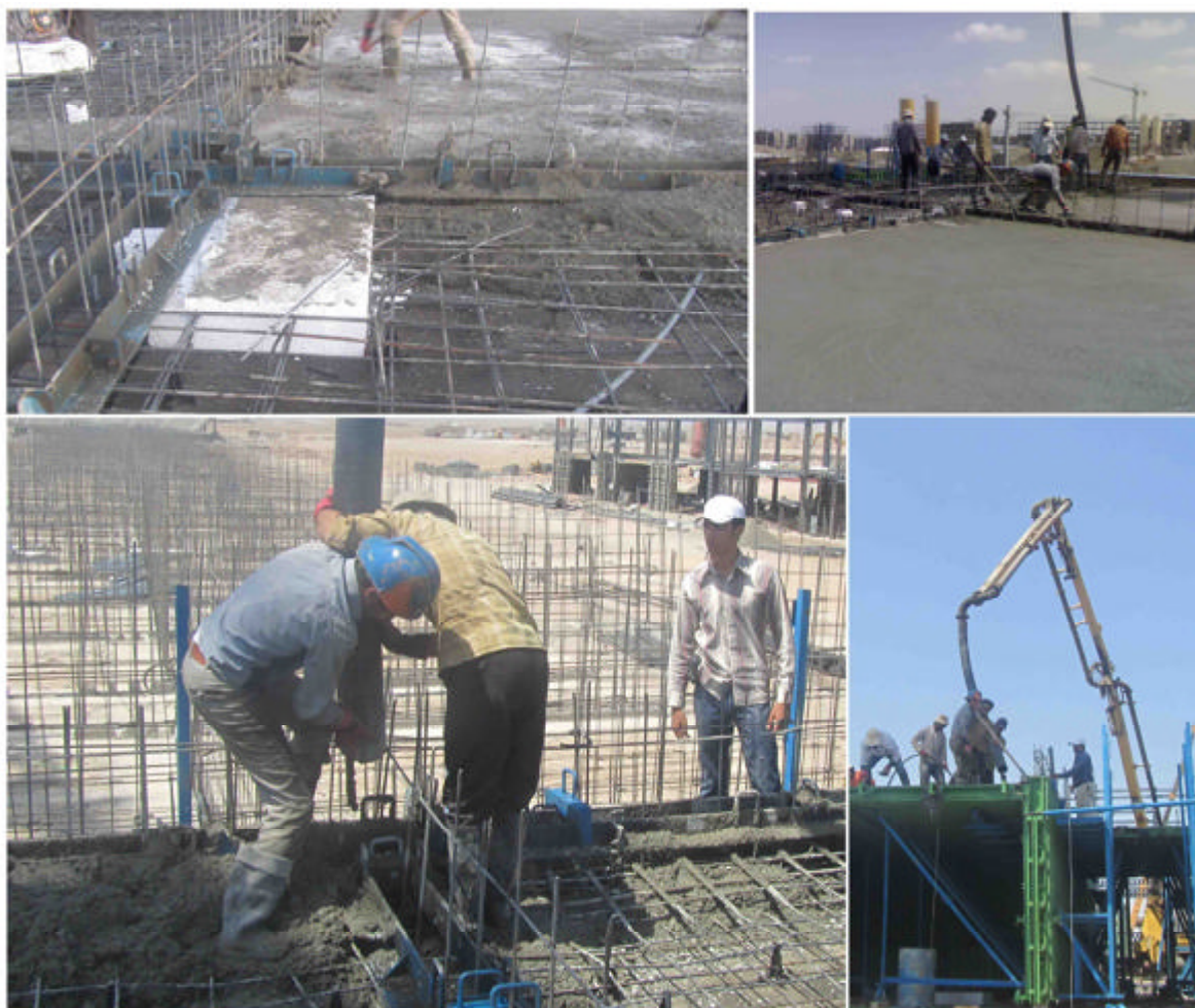
• مراحل مختلف بتن ریزی
