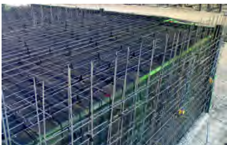
• نمایی از آرماتوربندی سقف و دیوار به صورت کلاف
