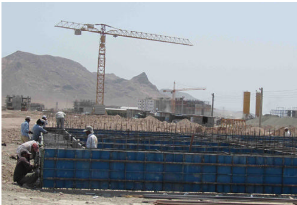
• بتن ریزی فنداسیون
