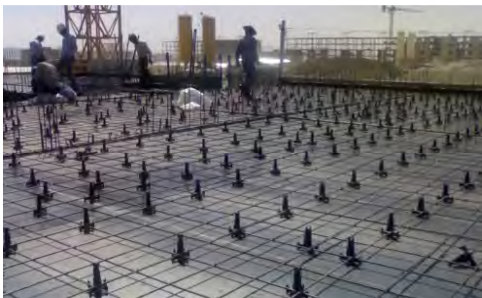
• نمایی از اسپیسر های سقف
