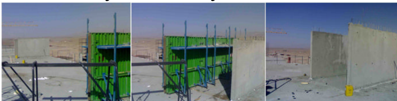
• قالب گذاری و بتن ریزی خرپشته در طبقه آخر
