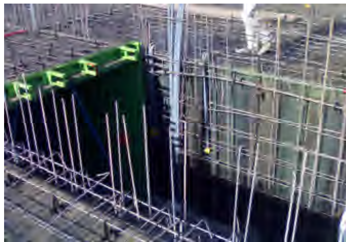
• نمایی از آرماتوربندی سقف و دیوار به صورت کلاف
