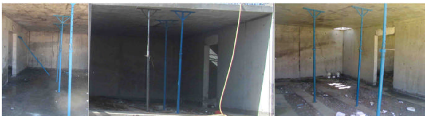
• قرار دادن جك های T در دهانه ها
