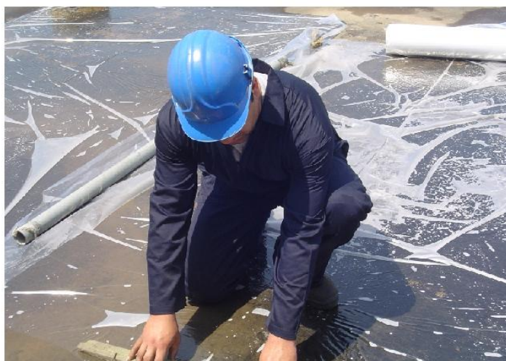
نمونه‌ای پوشش نایلونی روی سطح بتن
