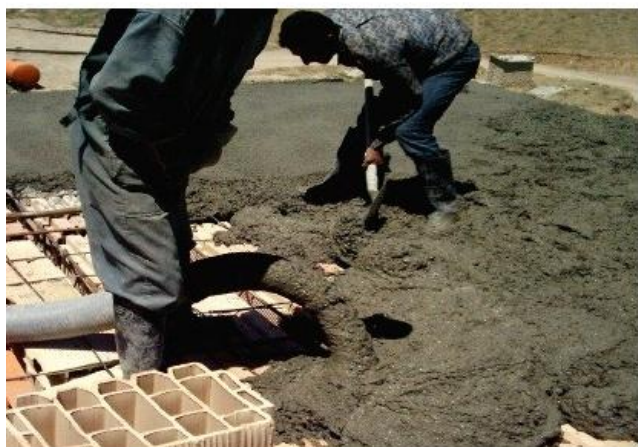
نمونه‌ای از ریختن بتن در محل نهایی
