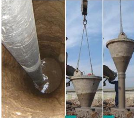
نمونه‌ای از یک لوله و قیف جهت بتن ریزی
