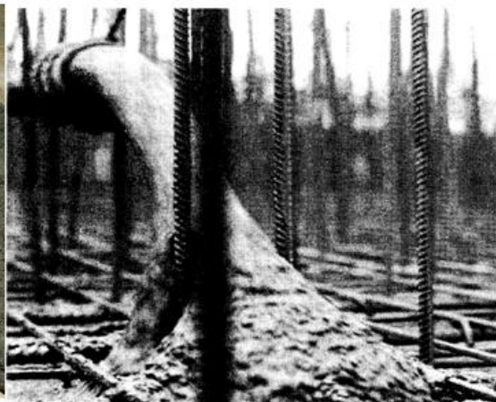
نمونه‌ای از حالت خمیری بودن بتن
