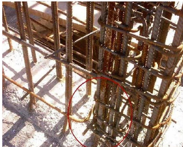
شکل (۵-۹۳) نمونه‌ای از عدم رعایت حداقل فواصل میلگردهای طولی و خسارت ناشی از نیروی جانبی
