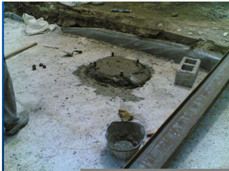
اجرای ماهیچه بتنی زیر کف ستون
