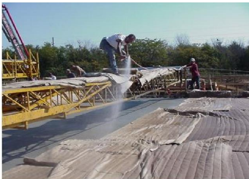
نمونه‌ای از عمل آوری با پارچه چتایی و خیس کردن متوالی آن
