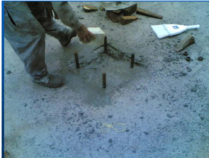
آماده سازی جهت اجرای ماهیچه زیر کف ستون
