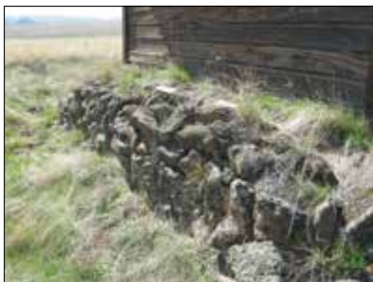
شکل ۳-۴۰ پی سنگی با سنگ لاشه
