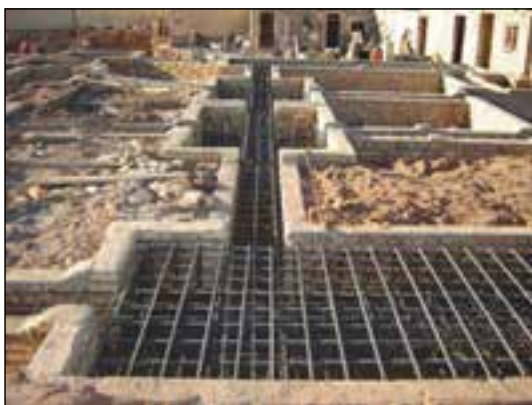
شکل ۳-۱۳۴ میلگردگذاری در پی کلاف بندی
