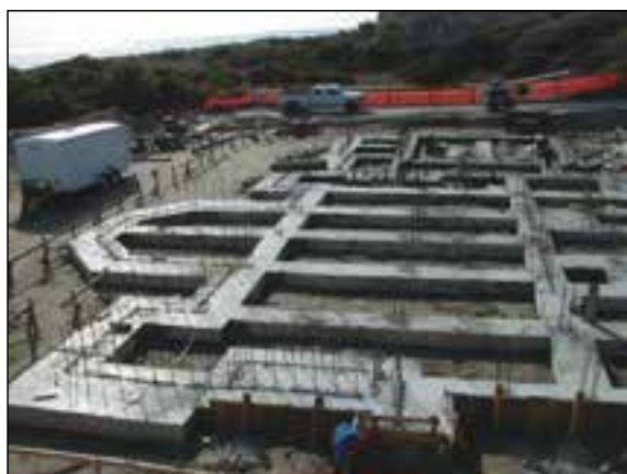
شکل ۳-۶۲ پی بتن مسلح نواری شبکه ای زیرستون
