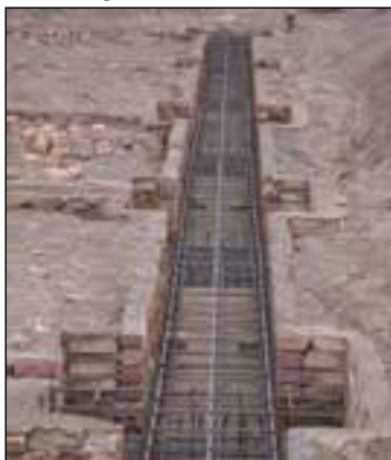
شکل ۳-۱۳۶ پی و شناژ قبل از بتن ریزی
