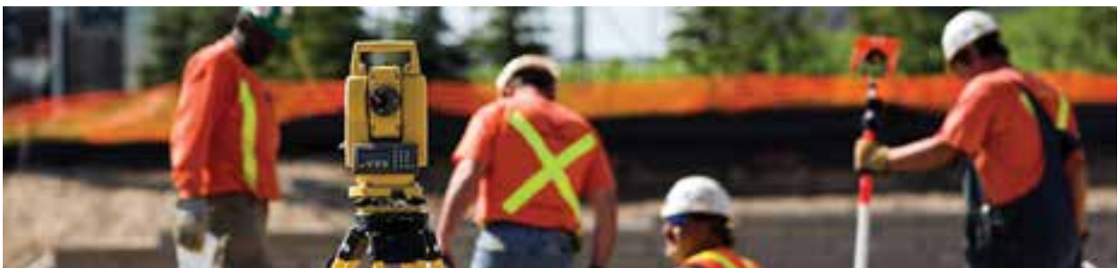
شکل ۴-۱. پیاده کردن با دوربین نقشه برداری
