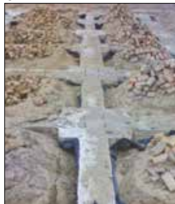
شکل ۳-۱۳۷ پی و شناژ بعد از بتن ریزی
