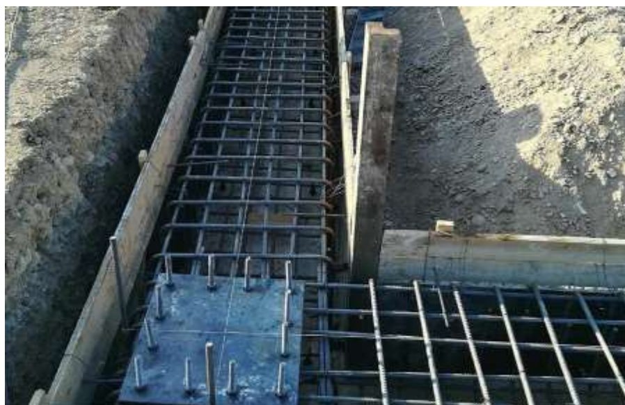
شکل (۴) - اتصال ورق و ستون در کارگاه (سایت)
